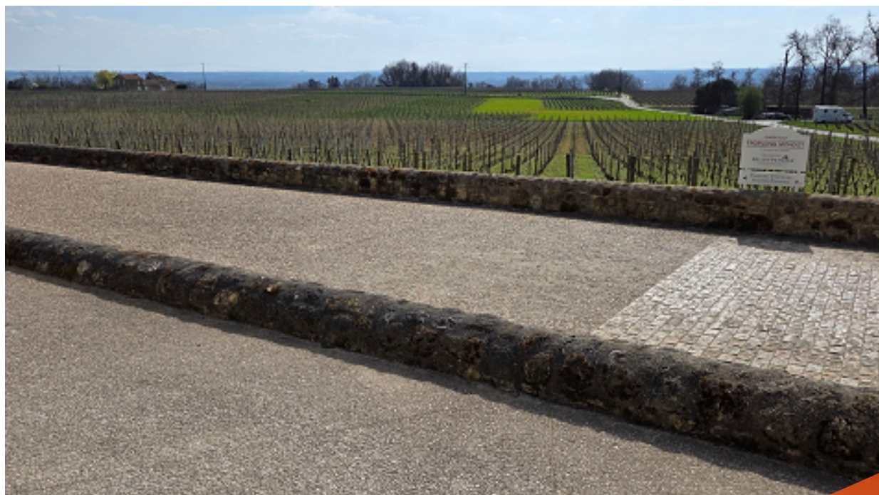
Voie d'accès au Château Troplong Mondot à Saint-Émilion (33) – Béton romain ciment bas carbone CEM III/B
