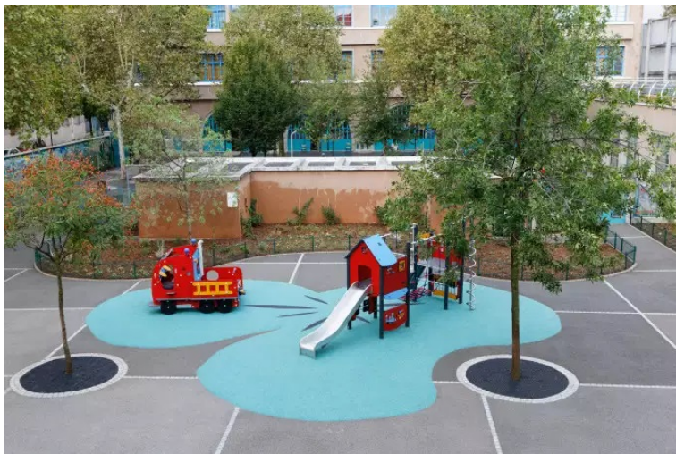
Aire de jeu : revêtement amortissant sur béton drainant
