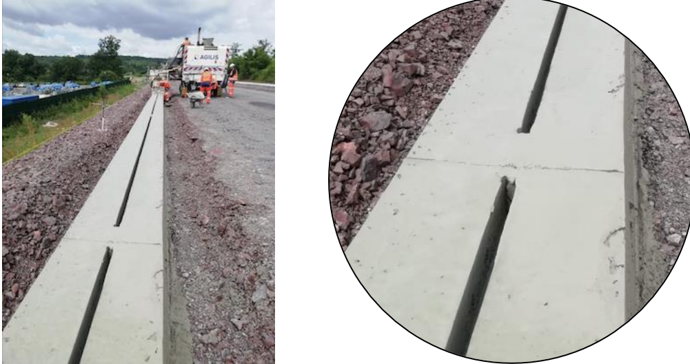
Pré-fissuration, première étape sur béton frais à la truelle @ AGILIS
