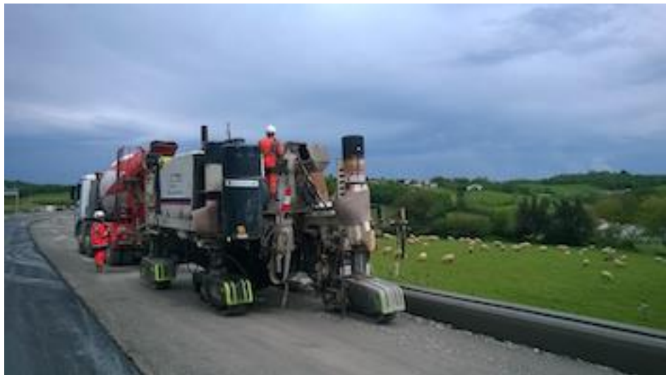
Coulage d'un caniveau à en bord de plateforme @SIGNATURE
