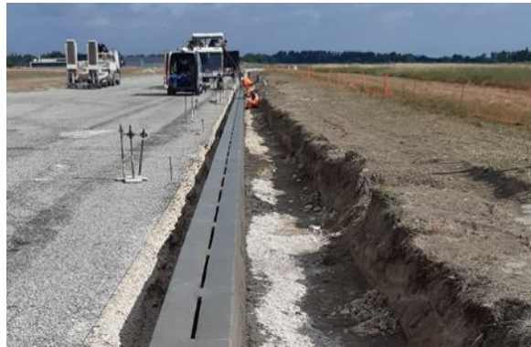
Coulage d'un caniveau à fente avec clés de voûte en bord de plateforme @AGILIS
