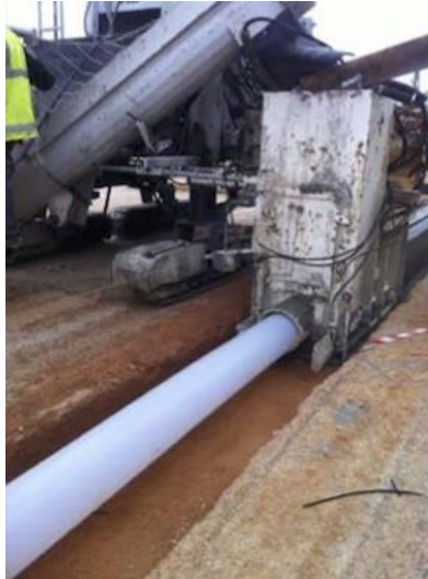
Gaine gonflable CF® de réalisation du diamètre intérieur du CAF @PROFIL06
