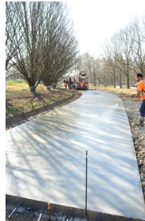
Mise en œuvre du béton
