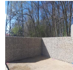
Les murs en gabion
