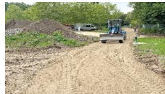
Les fonds de forme des allées à réhabiliter
