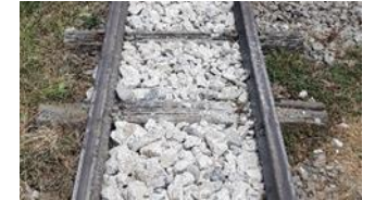
Le remplacement du ballast du chemin de fer
