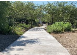
La production de béton 100% recyclé
