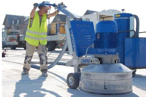
Machine pour béton durci
