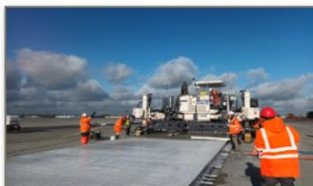
AGILIS a réalisé des travaux comprenant le terrassement, la mise en place des réseaux secs et humides, le traitement du sol, et l'utilisation de grave traitée au liant hydraulique. Sur une sous-couche en béton poreux de 10 cm d'épaisseur et la plateforme a été revêtue avec du béton balayé de type BC6 d'épaisseur totale de 40 cm.
