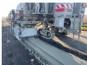
PROFIL06 réalise une nouvelle bordure spéciale de protection de piste cyclable type JMC-double caniveau sur l'avenue de la Caprice à Escalquens (31).
