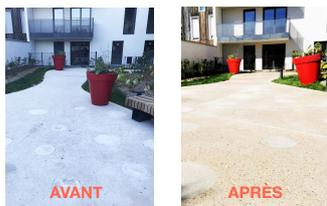
A Bézons, EUROTECH'FLOOR a rénové une allée piétonne grâce à du micro-piquage, et ainsi donné un véritable éclat au béton désactivé.
