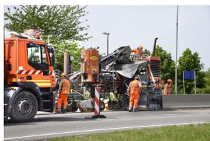
Sur la RD446 à Evry, AXIMUM a démolé la mini-DBA existante puis reconstruit une DBA en terre-plein central sur 1 050 m.
