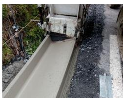
Réalisation d'une cunette de montagne pour l'accès à la station de Luz Ardiden dans les Pyrénées (65) par PROFIL06.
