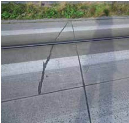
F5 Fissure oblique en pleine dalle
