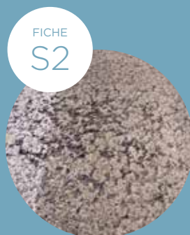
ECAILLAGE OU FAÏENCAGE DE SURFACE
