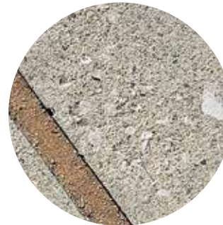
Surface de béton hydrosablée
