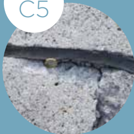
DÉPART DE MATÉRIAU EN BORD DE DALLE OU DE FISSURE
