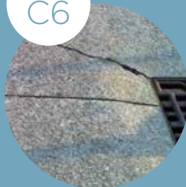
DÉPART DE MATÉRIAU EN COIN DE DALLE OU SINGULARITÉ
