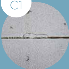
EPAUFREUR OU CASSURE EN BORD DE JOINT DE DALLE
