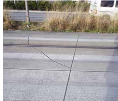
F6 Fissure oblique de bord à bord
