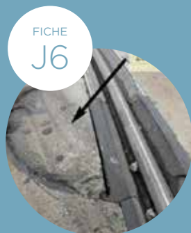
DÉSORDRE ENTRE LE JOINT DU RAIL CENTRAL DU TCSP ET LE BÉTON DE LA PLATE-FORME
