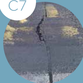
DÉPART DE MATÉRIAU EN « MILIEU DE DALLE »
