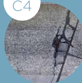
MORCELLEMENT ENTRE FISSURES RAMIFIÉES
