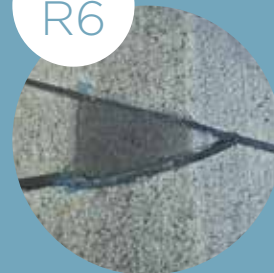
LE JOINTOIEMENT DE CASSURE DE DALLE
