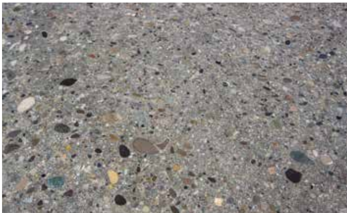
Surface de béton poncée
