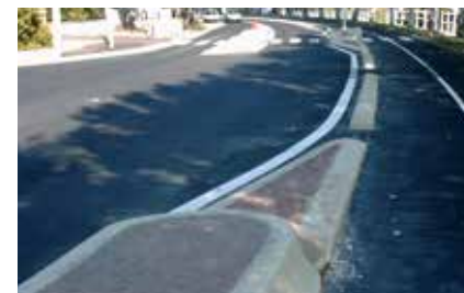
▲ Aménagement d'îlot de séparation avec bordures du type Mini-GBA, type 11 et séparateur de voies franchissable.
