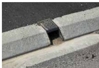
▲ Intégration d'avaloir en fonte dans une bordure-caniveau.
