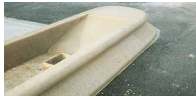
▲ Bordure pour îlot directionnel d'une hauteur de 50 cm.
