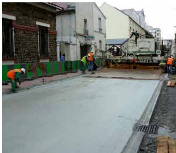
▲ Bordure-caniveau et chaussée en béton dépolluant. La photo ci-dessus montre un chantier où des bordures et des caniveaux, coulés au préalable en béton au TiO 2 , servent au guidage altimétrique de la slip form qui met en place le béton de chaussée également au TiO 2 .
