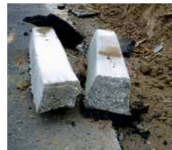
▲ Accrochage du béton coulé sur l'enrobé.
