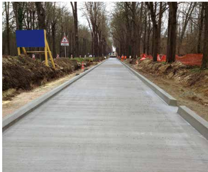
▲ La machine de réalisation de la plate-forme du TCSP peut intégrer les caniveaux et bordures.
