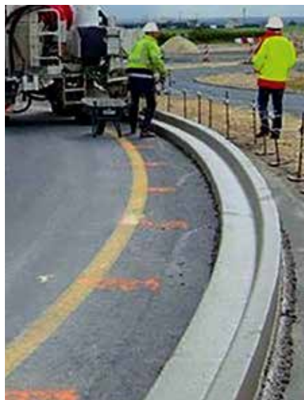
▲ Caniveau de type CS3 avec bordure.
