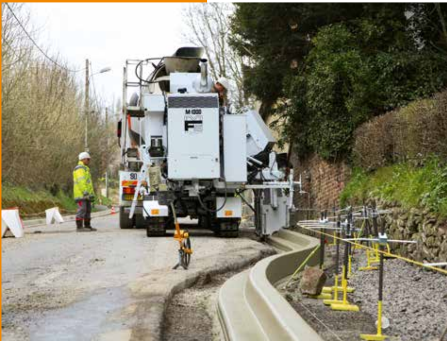
▲ Coulage d'une bordure par machine à coffrage glissant asservie sur fils.
