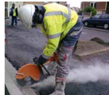
▲ Sciage d'un joint de retrait/flexion.
