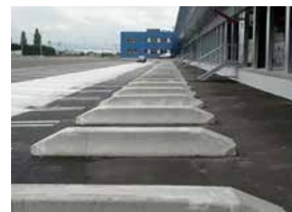
▲ Îlot de guidage sur quai de déchargement PL.
