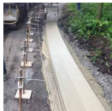
▲ Détail de l'extrusion d'un caniveau CC1.
