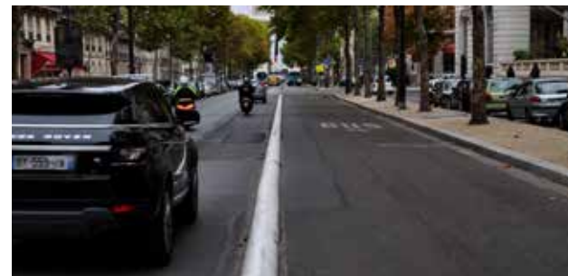
▲ Séparateur de voies franchissable.
