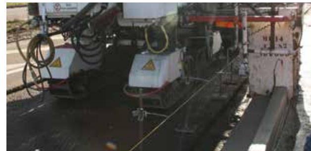
▲ Bordure pour trottoir avec caniveau intégré.
