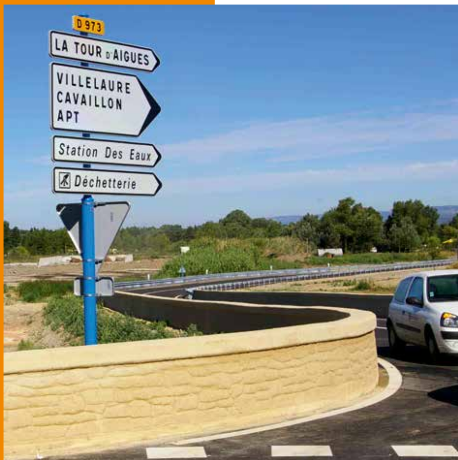
▲ Impression, directement par l'extrudeuse, d'un décor « pierre » sur un muret.
