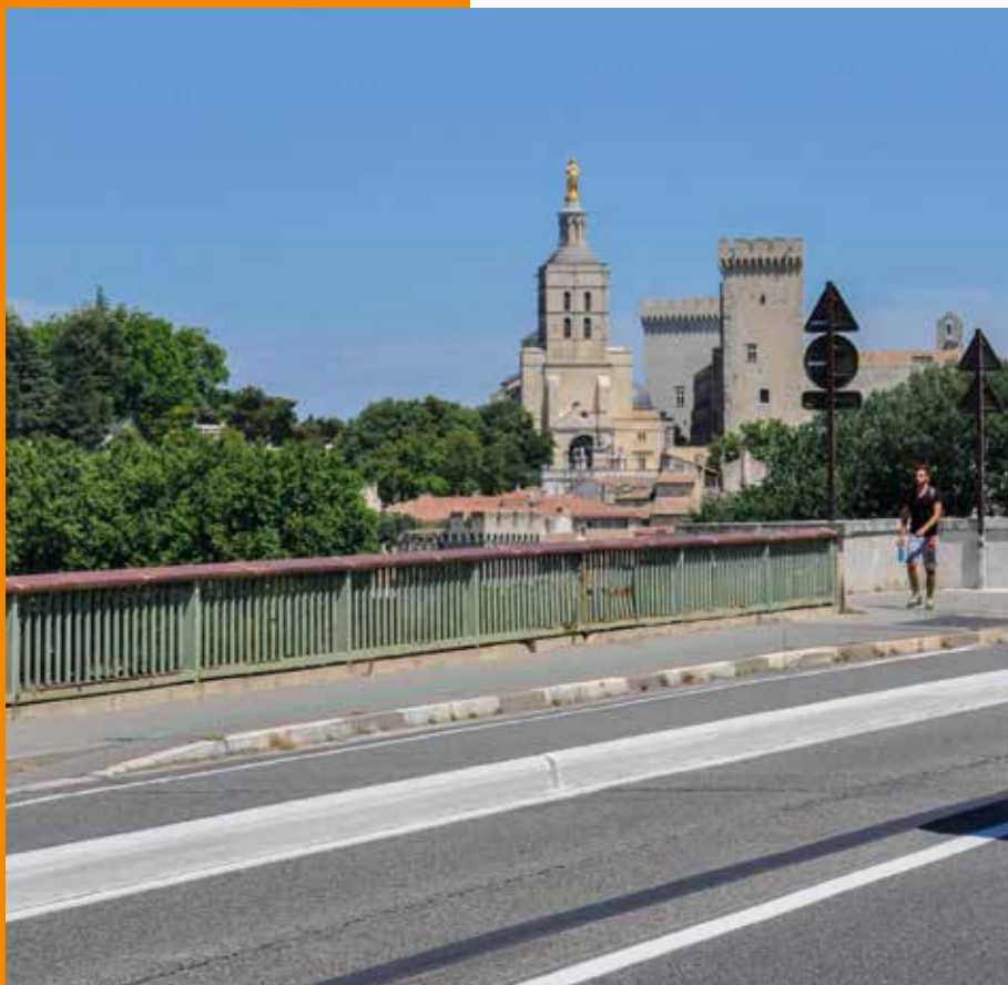
▲ Bordure de délimitation des voies, réalisée sur l'enrobé existant.
