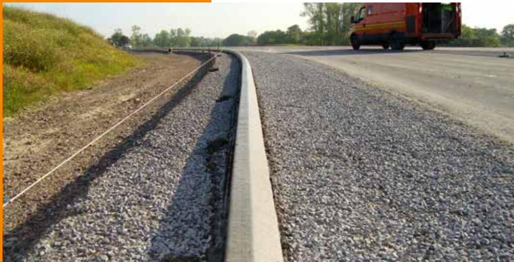
▲ Bordure d'accotement réalisée sur mesure.
