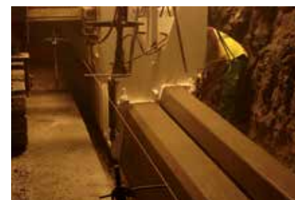
▲ Caniveau à fente avec bordure intégrée, en tunnel.
