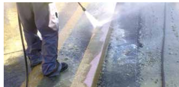
▲ Désactivation d'une bordure en béton de mignonnette.
