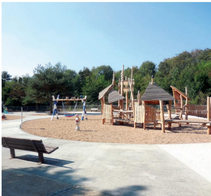
Parc des Chanteraines : l'une des deux aires de jeux rénovées en béton drainant, avant réouverture au public. Au total, 112 t de ciment et 550 t de gravillons ont été utilisées pour réaliser 3 900 m<sup>2</sup> de béton drainant.
