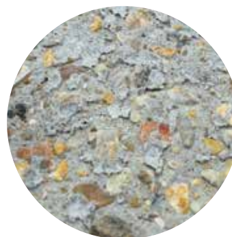
LAITANCE DE BÉTON
