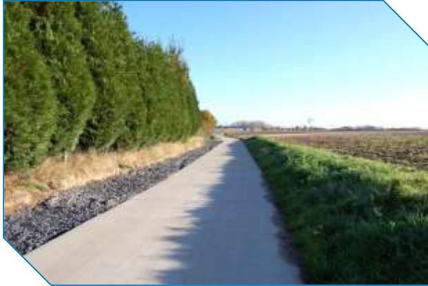
Voiries urbaines → Utilisation généralement de dalles non goudonnées sans fondation
