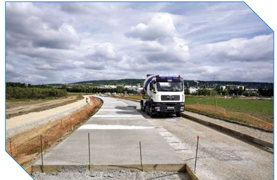
Béton de fraisats à Chanteloup-les-Vignes (Ecoparc)
