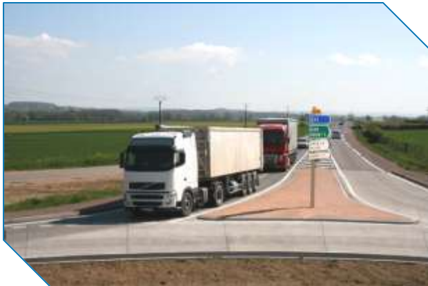
Giratoires → Structure BAC ou à dalle goudonnée
