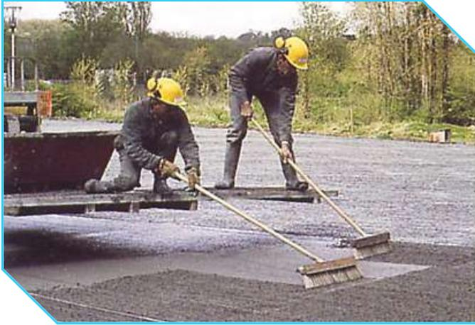
*Balayage axial du béton*
