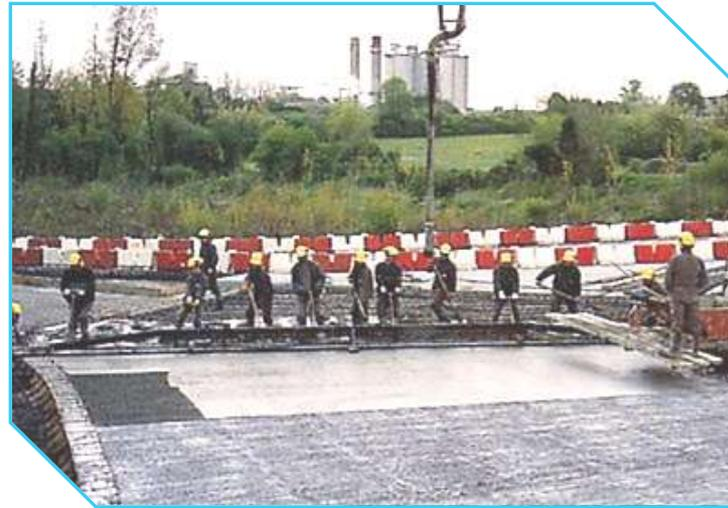
*Règle vibrante manuelle de 11 m de long spécifiquement réalisée pour ce chantier*
