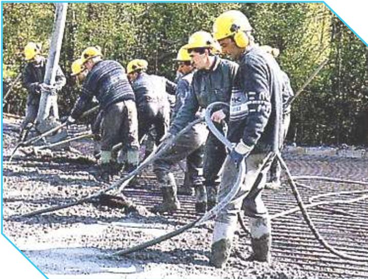
*Le béton est vibré à l'aiguille aussitôt après son coulage*
