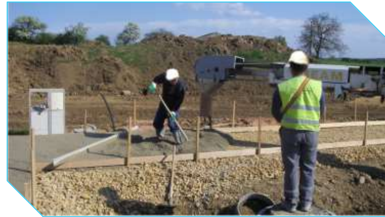
Réglage de la couche après coulage
