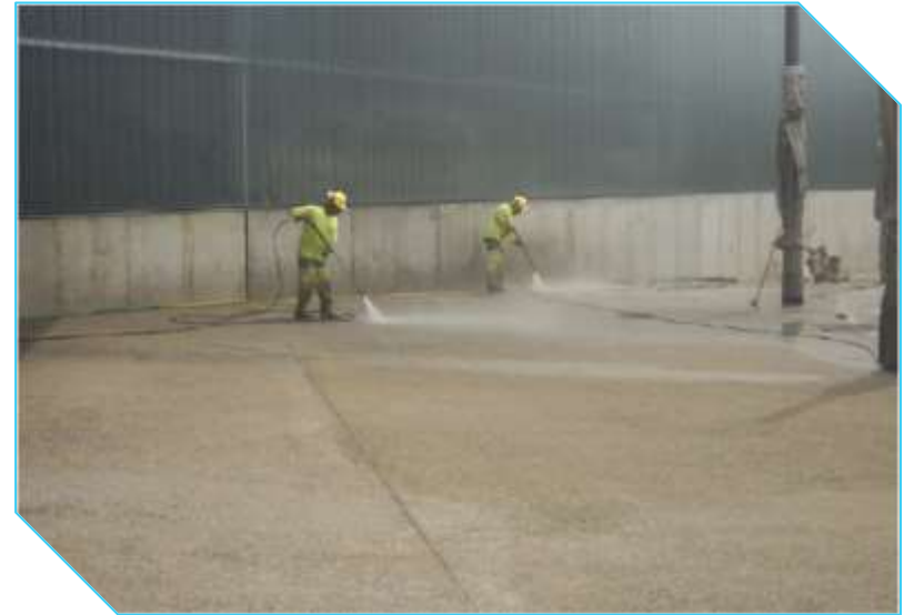
Lavage et suppression de la laitance
