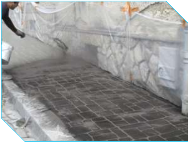
Epandage du colorant et durcisseur de surface puis lissage pénétration
