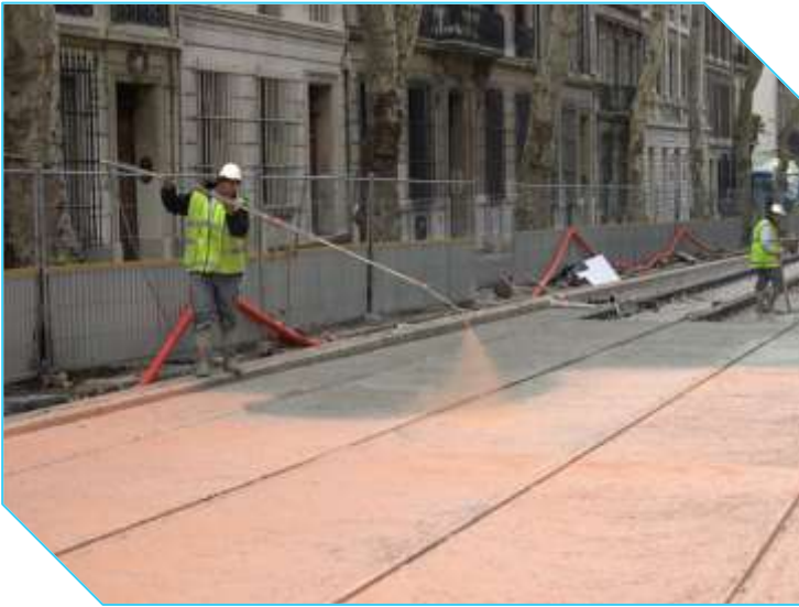
Pulvérisation du retardateur de prise de surface
