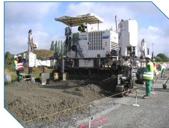
Époque de bétonnage
