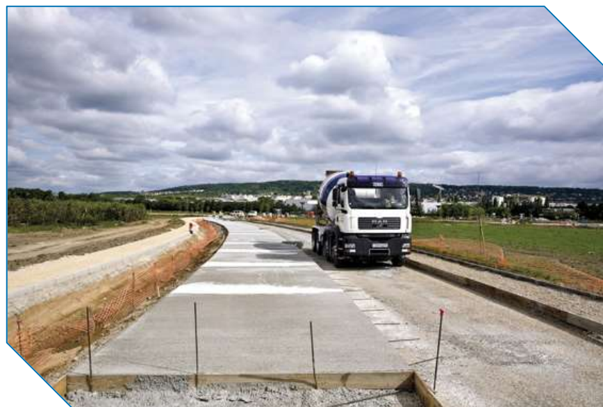
Béton de fraisats à Chanteloup-les-Vignes (Ecoparc)
