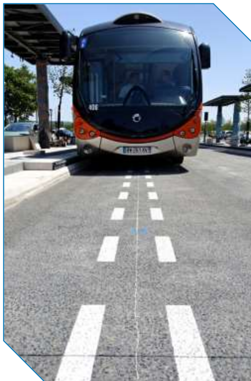
Voiries autoroutières, BHNS, tramways et aires de stockage lourd (zones aéroportuaires et portuaires) → Structures goujonnées
