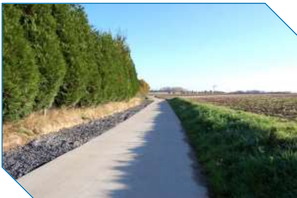
Voiries urbaines → Utilisation généralement de dalles non goujonnées sans fondation
