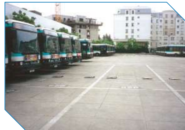
Zones d'arrêt de bus ou de stationnement (aires autoroutières) → BCMC pour lutter contre l'orniérage
