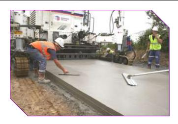
Il est puissamment vibré par des aiguilles vibrantes placées à l'intérieur du moule, Assure son serrage et la tenue de l'ouvrage dès sa sortie du coffrage
