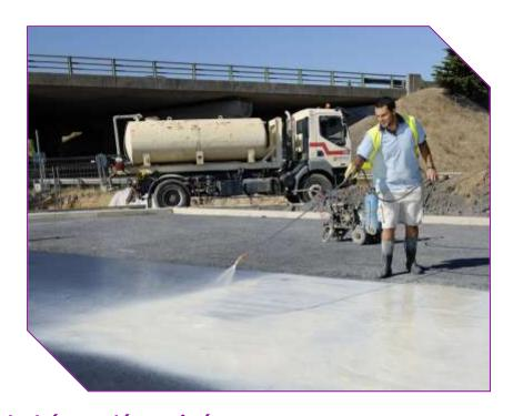
Dans le cas du béton désactivé, une deuxième cure, ou éventuellement un bouche-pores, doit être réalisé après lavage
