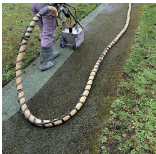
Photo 94 - Nettoyage par pression d'eau suivi d'aspiration.
