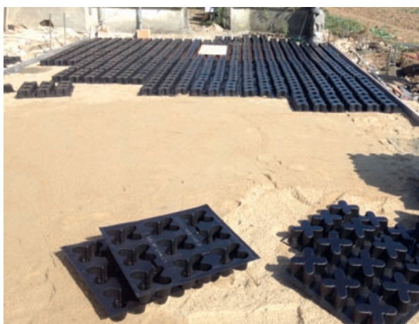
Photo 64 - Pose des moules (système Grasscrete®).
