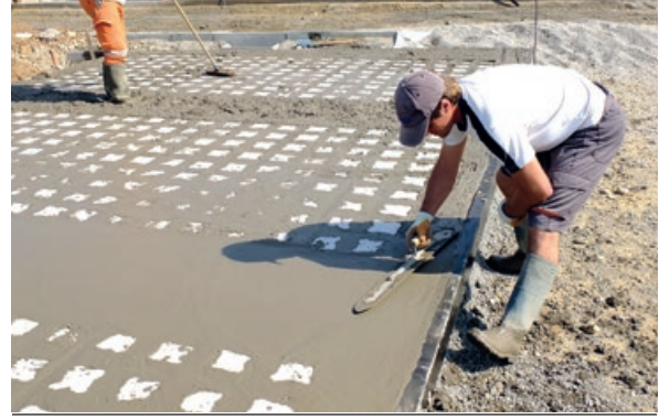
Photo 70 - Talochage du béton (système ViaVerde®)
