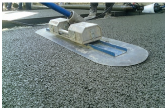
Photo 51 - Passage de la lisseuse vibrante.
