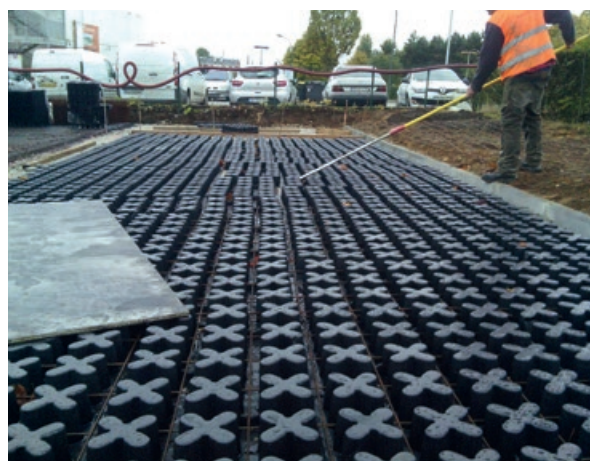
Photo 65 - Réalignement des moules (système Grasscrete®).
