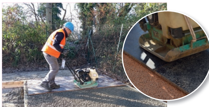
Photo 53 - Compactage au patin vibrant.
