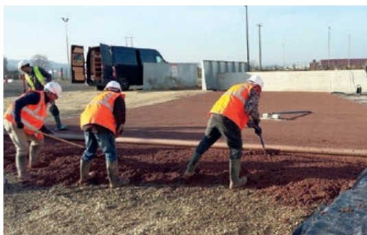
Photo 52 - Nivellement au roller-striker.
