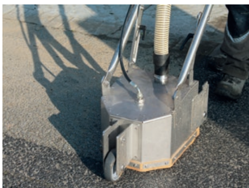
Photo 99 - Le nettoyeur injecte de l'eau sous pression.
