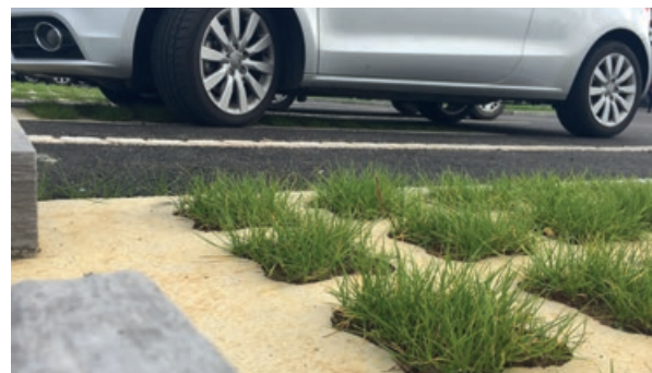
Photo 74 - Engazonnement des alvéoles (système ViaVerde®).
