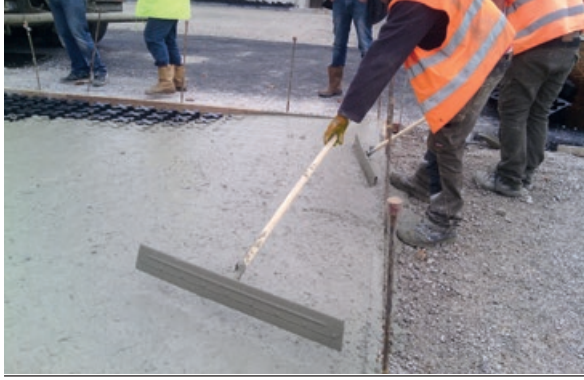
Photo 69 - Répandage à la raclette (système Grasscrete®)
