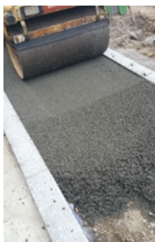
Photo 55 - Compactage du béton drainant.
