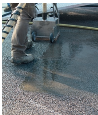
Photo 100 - Le nettoyeur aspire la boue produite.
