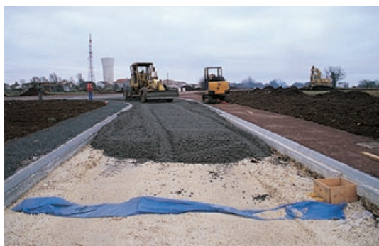
Photo 54 - Répandage du béton drainant à la niveleuse.
