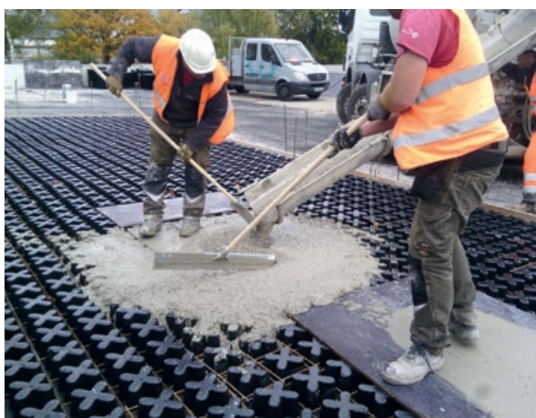
Photo 67 - Coulage du béton sur les moules Grasscrete®
