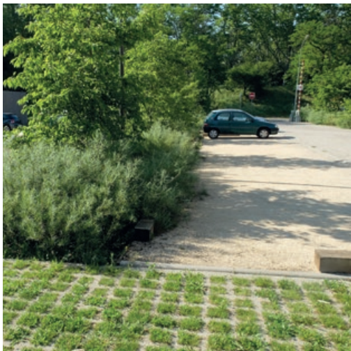
Photo 5 - Noue paysagère associée à un revêtement drainant.
