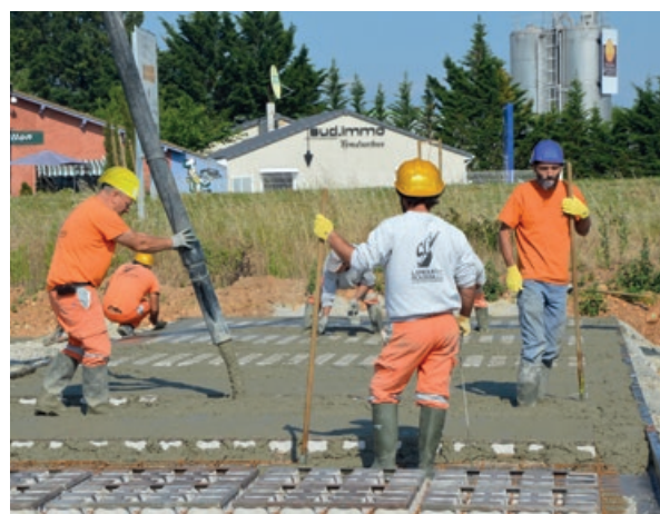
Photo 68 - Coulage du béton sur les moules ViaVerde®
