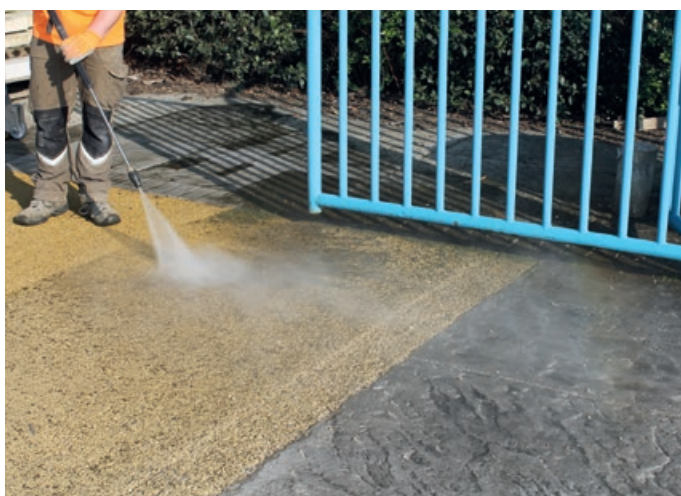
Photo 93 - Lavage au nettoyeur haute pression.
