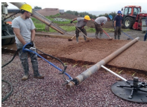
Photo 46 - Coulage du béton et réglage au « roller-striker ».
