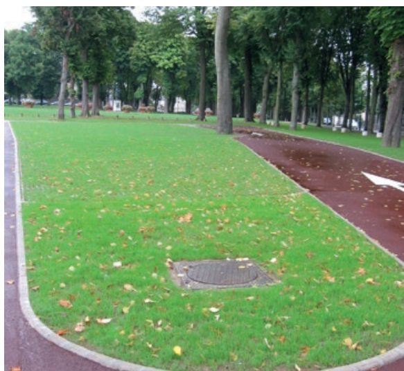
Photo 87 - Revêtement en dalles drainantes engazonnées.
