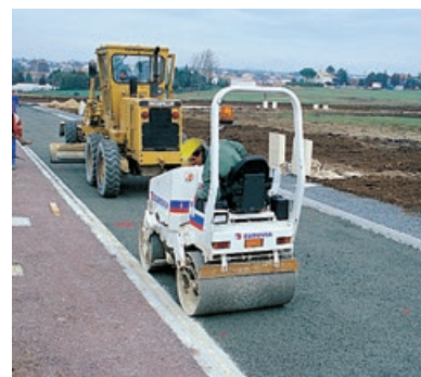
Photo 56 - Atelier de mise en œuvre du béton drainant.
