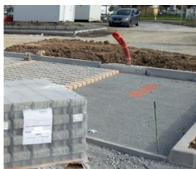
Photo 79 - Lit de pose en gravillons.
