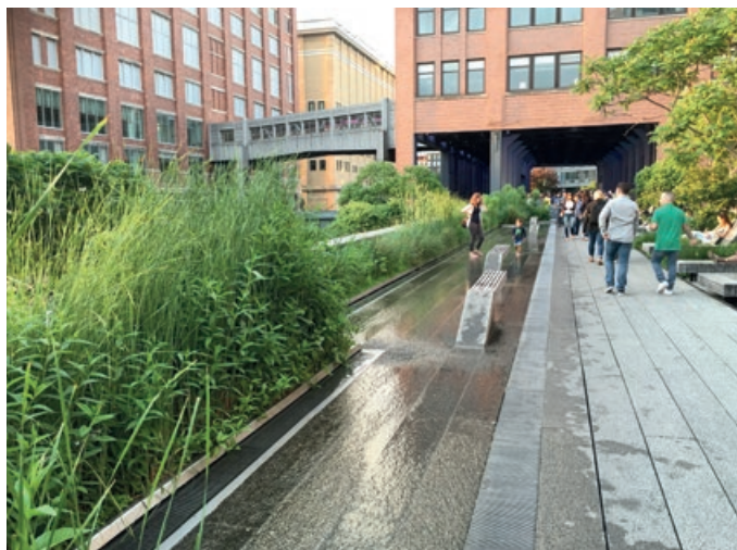
Photo 15 - Passage en produits préfabriqués avec brumisateurs.
