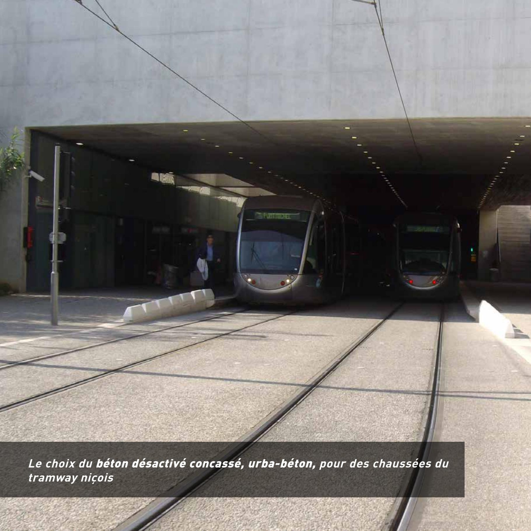
*Le choix du béton désactivé concassé, urba-béton, pour des chaussées du tramway niçois*
