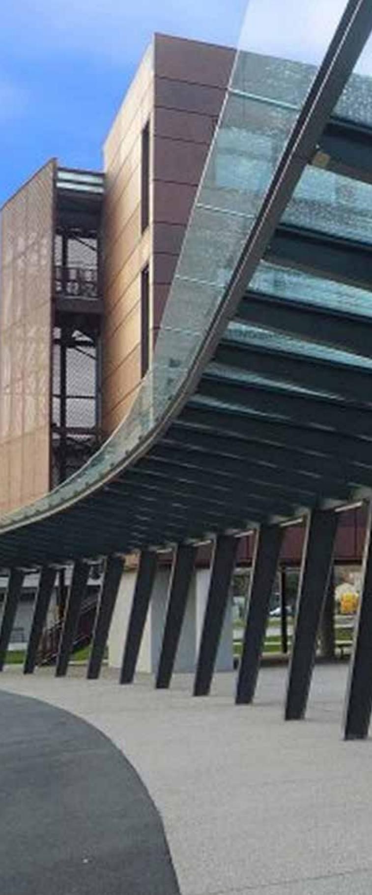
La mise en œuvre de cet urba-béton a donné entière satisfaction. C'est l'entreprise Bâtiment du Grand Lyon qui a été chargée de l'exécution de l'ensemble des revêtements extérieurs en béton, soit 8500 m<sup>2</sup> au total. La difficulté est de maîtriser la technique pour maintenir l'homogénéité de l'ensemble et une granulométrie identique sur une telle surface.
