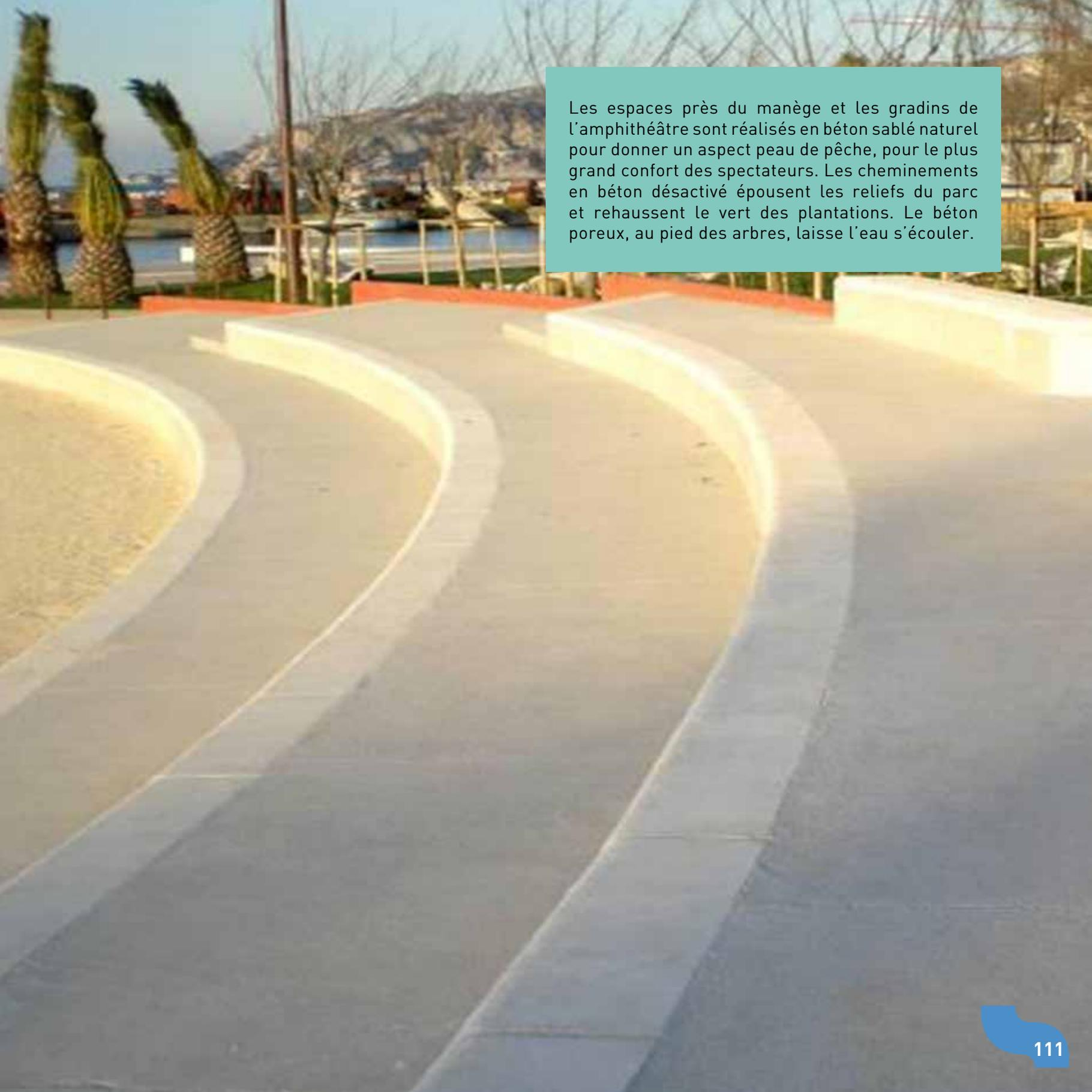
Les espaces près du manège et les gradins de l'amphithéâtre sont réalisés en béton sablé naturel pour donner un aspect peau de pêche, pour le plus grand confort des spectateurs. Les cheminements en béton désactivé épousent les reliefs du parc et rehaussent le vert des plantations. Le béton poreux, au pied des arbres, laisse l'eau s'écouler.
