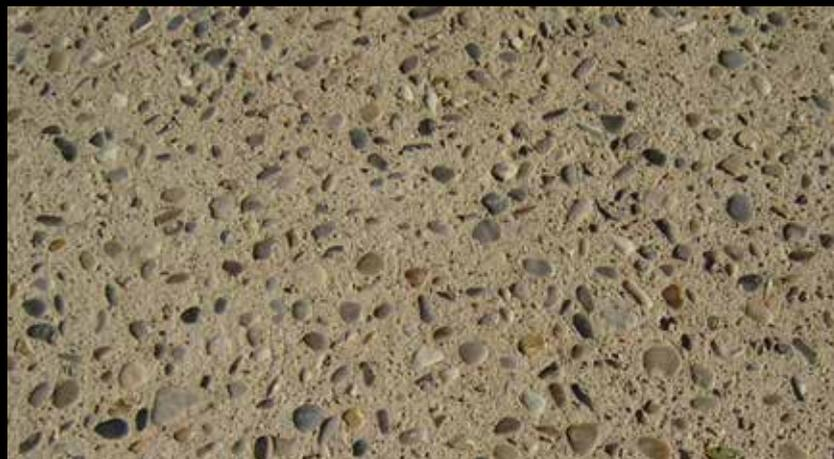
**A l'image d'un lit de rivière, les circulations en béton désactivé de sable riche en granulats. Au pied des chênes pubescents, un béton bouchardé en hommage à la beauté des lieux.**
