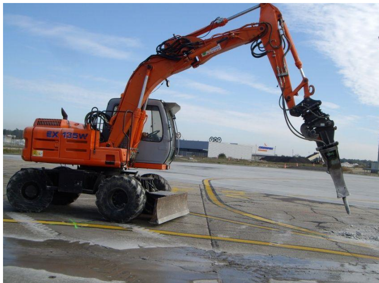
Photo 15 : Démolition au BRH
