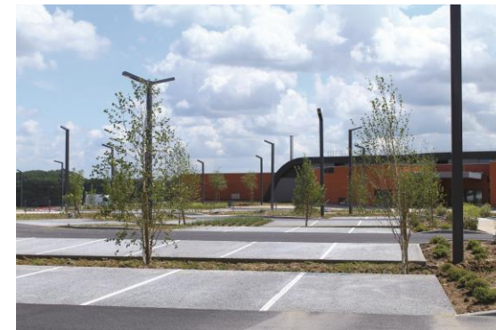
Béton drainant coulé en place
