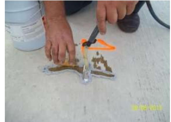
Collage d'une fissure passive par injection sous pression
